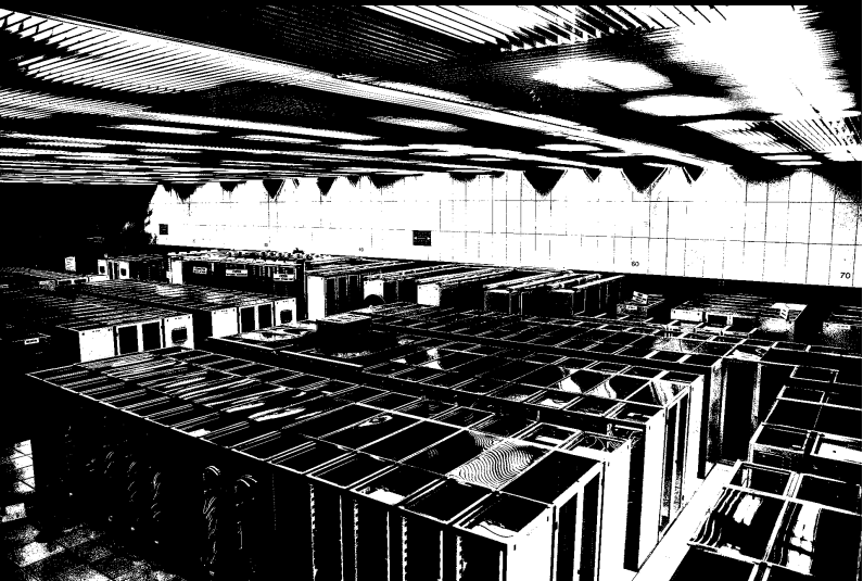
Salle des serveurs au CERN (Suisse) – source : Wikipédia
